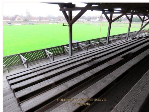
Слика 33: Дрвене трибине ФК „Обилић“ НК
