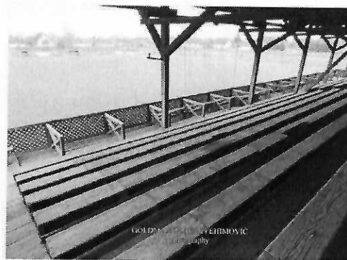
Слика 33: Дрвене трибине ФК „Обилић“ НК
